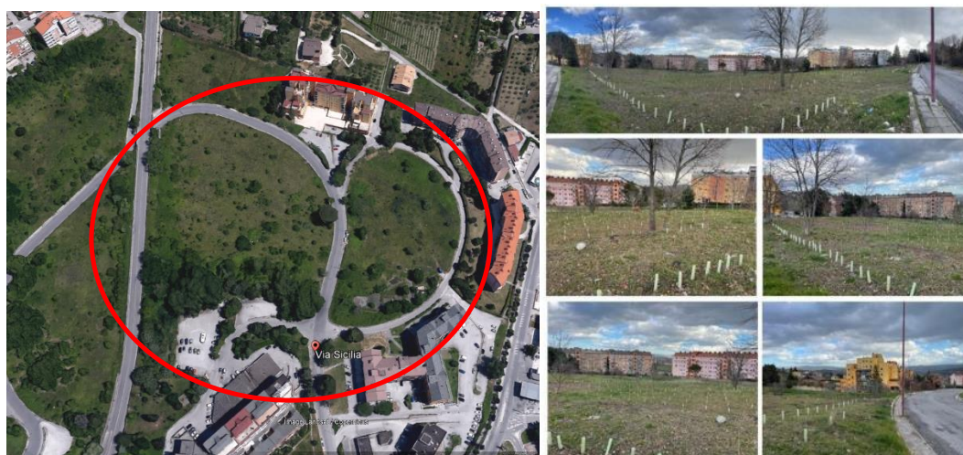
FIGURA 7 - IMPIANTO DI VIA SICILIA NEL COMUNE DI CAMPOBASSO REALIZZATO NEL 2022
